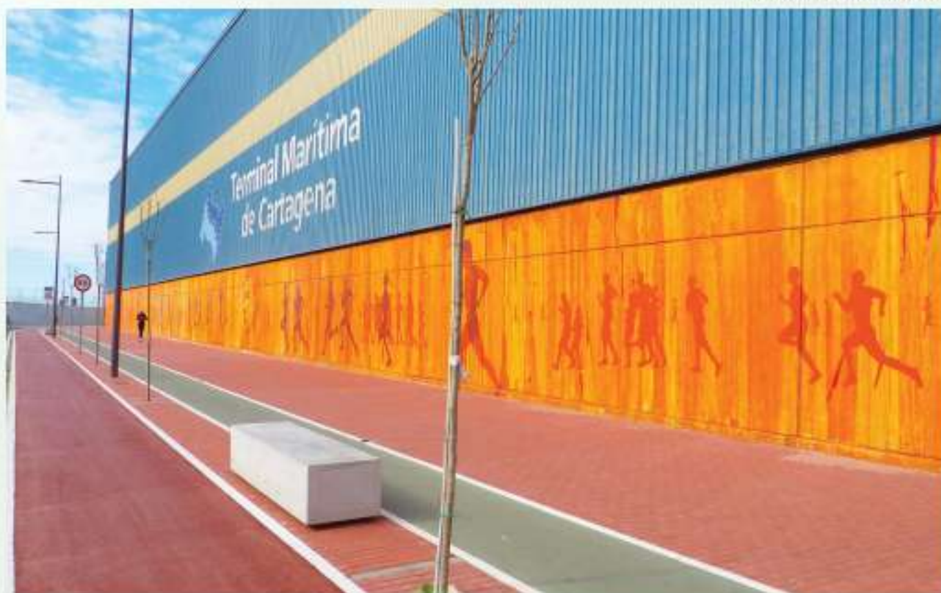
Banco con Luminaria
